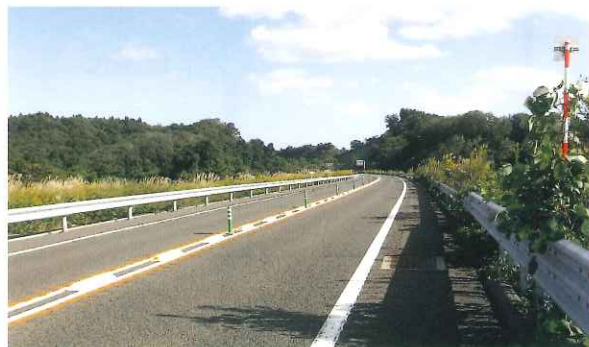
ワイヤロープ式車線区分柵設置前
