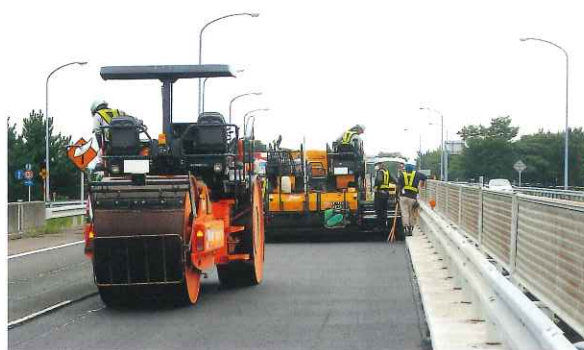
施工中(イメージ)
