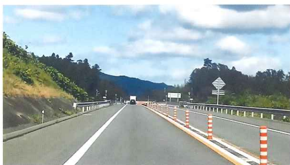
ワイヤロープ式車線区分柵設置前
