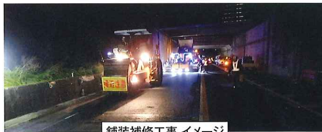
舗装補修工事 イメージ
