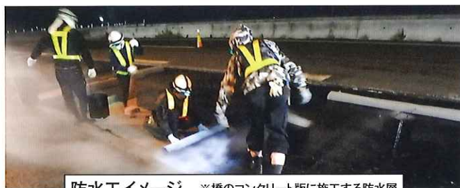
防水工イメージ ※橋のコンクリート版に施工する防水層
