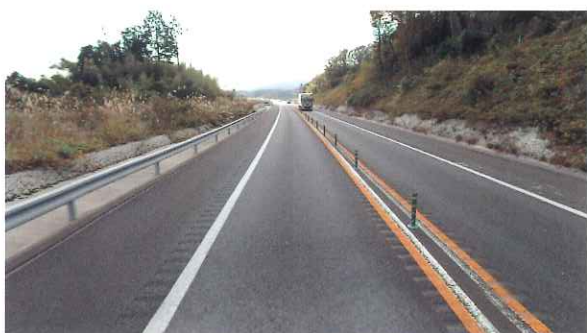
ワイヤロープ式車線区分柵設置前
